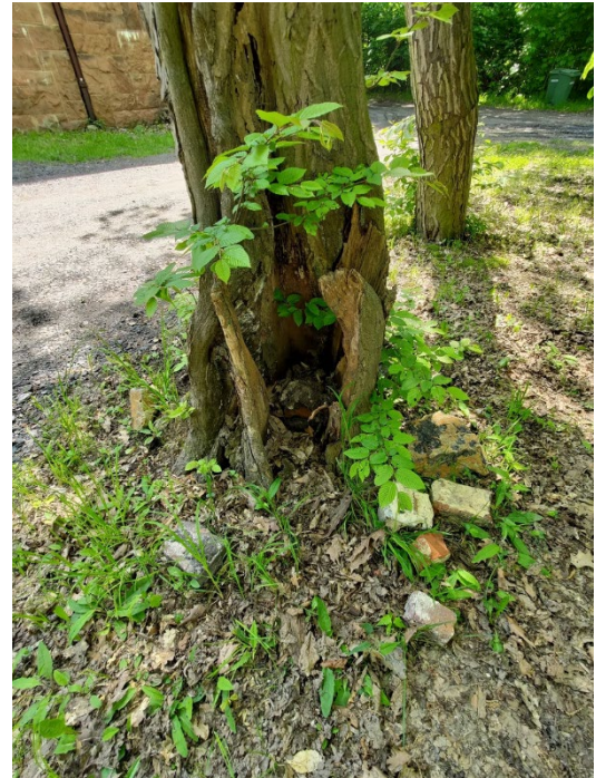
fot. 12 Skrajnia drogi bezpośrednio przy odziomku, zanieczyszczenie odpadami budowlanymi
