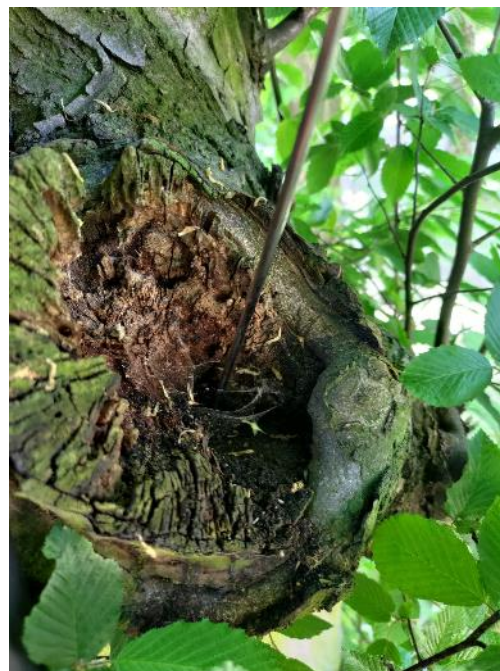
fot. 6 Ubytek na pniu
