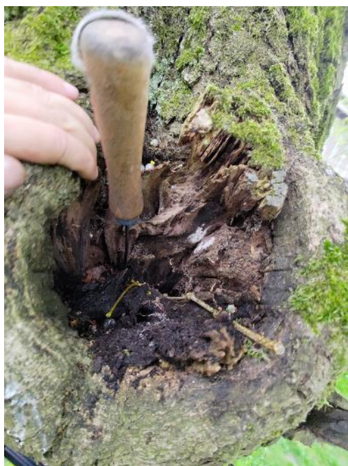
fot. 9 Ubytek na przewodniku N
