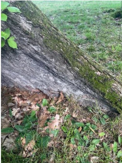
fot. 3 Sonda wbita w ubytek w nabiegu
