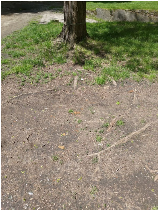
fot. 15 Wyplycone, uszkodzone mechanicznie korzenie
